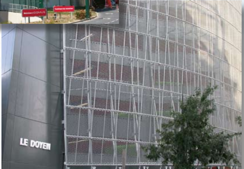
Parking Europole à Grenoble Atelier A & Amplitude architectes
