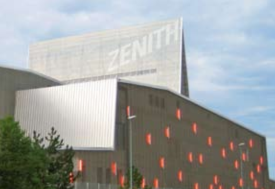
Zénith de l'agglomération dijonnaise Cabinet d'architecture Chaix & Morel et associés
